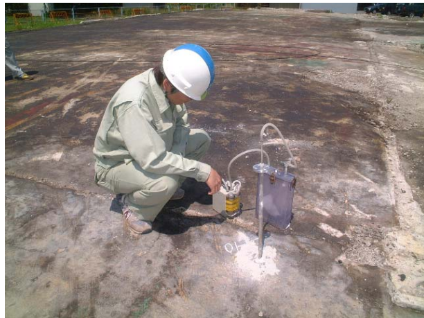
土壤ガス採取状況
